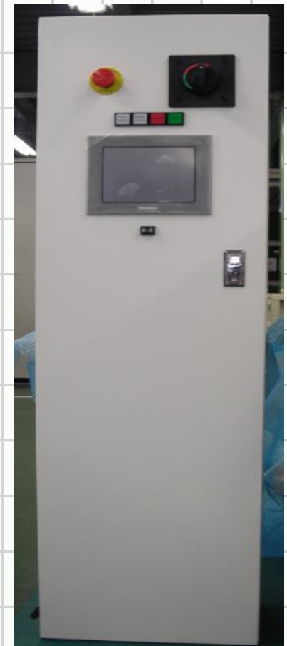
ガス精製装置 制御盤
