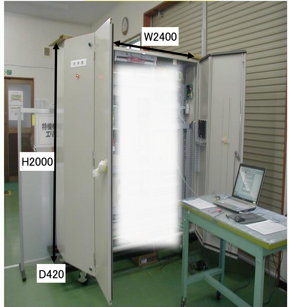
立体駐車場用制御盤
