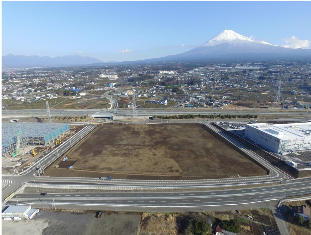
富士市 第二東名IC周辺地区 区画整理事業 2街区造成工事
