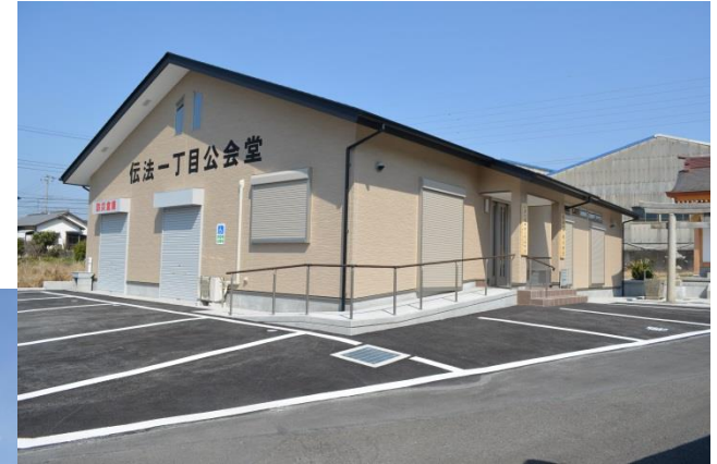
伝法丁目公会堂新築工事
