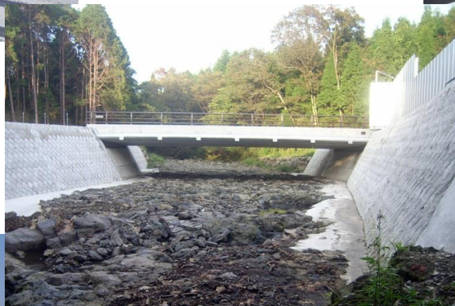
富士市 桑崎千束線・御所舟橋 架替工事
