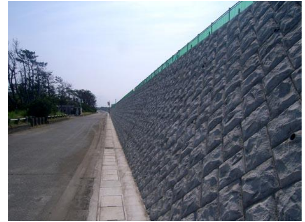
静岡県田子の浦港管理事務所 吉原海岸裏法護岸工事
