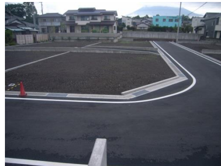
旭化成 伝法ハーベルタウン造成工事
