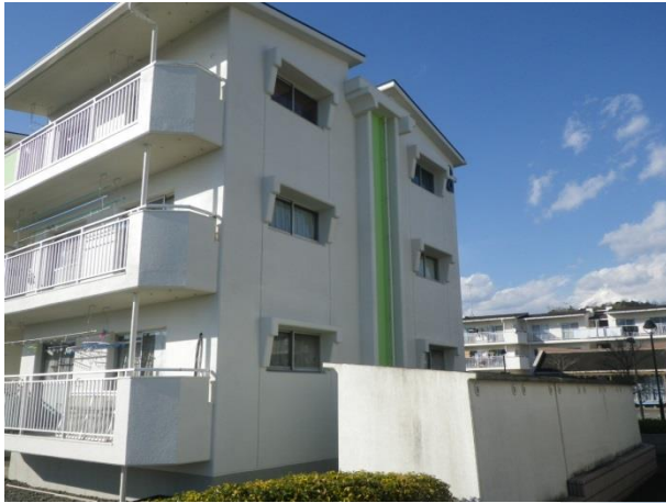
富士市 公営住宅二子団地G棟外壁修繕工事
