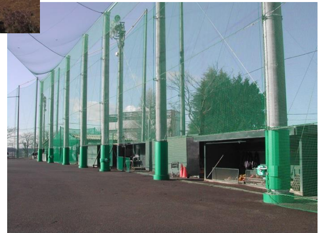
静岡県富士土木事務所 富士宮東高校防球ネット改修工事
