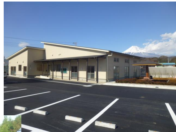
各種駐車場舗装工事
