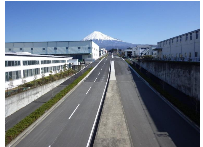
富士市 本市場大淵線(大淵工区)街路築造工事その1
