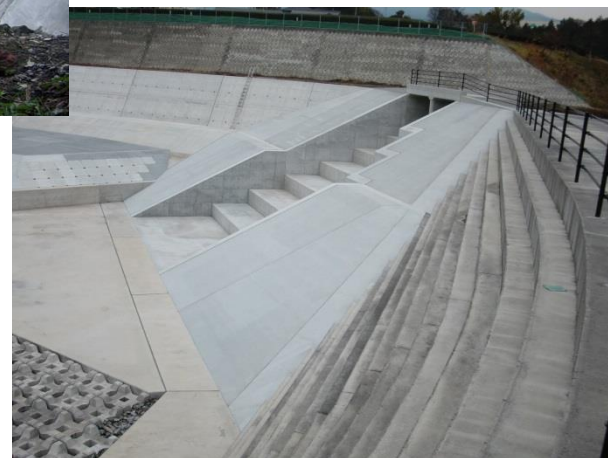
静岡県富士土木事務所 伝法沢川局地豪雨 緊急対策事業 伝法沢川流入工
