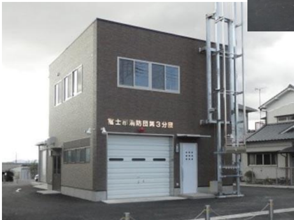
富士市 消防団3分団詰所 新築工事
