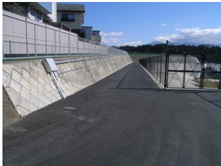
静岡県富士土木事務所 伝法沢川局地豪雨緊急対策事業 管理用道路舗装
