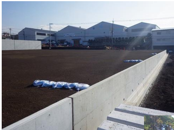
富士市 第二東名IC周辺地区 土地区画整理事業 11街区造成工事
