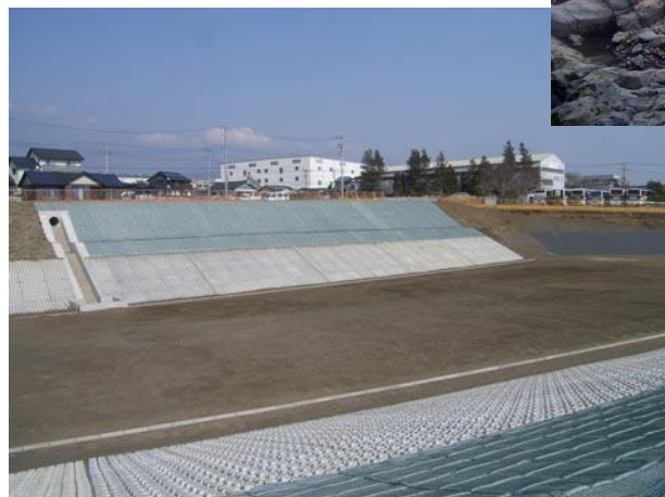
富士市 第二東名IC周辺地区土地区画整理事業 2号調整池築造工事
