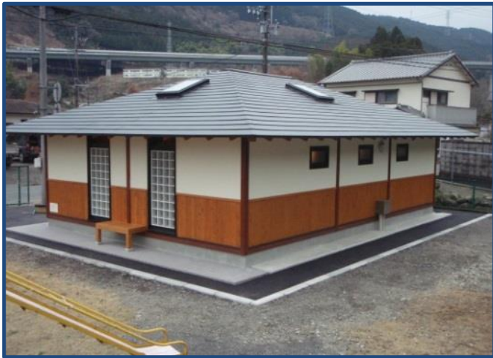
東海自然歩道富士川公衆トイレ建築工事
