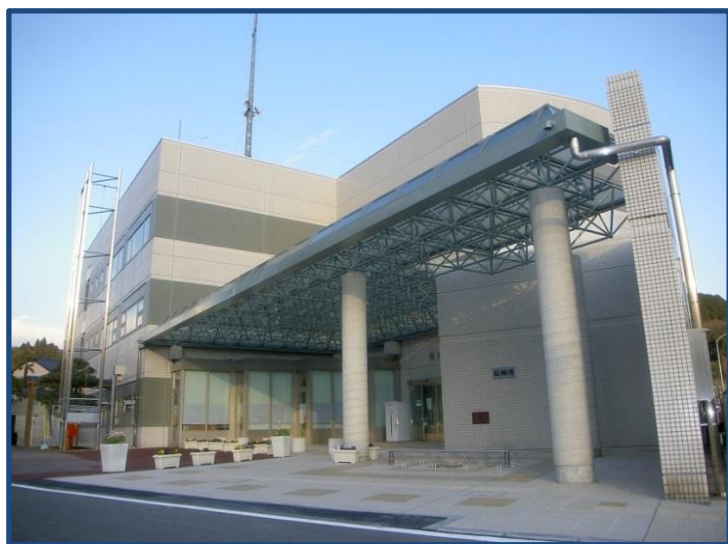
富士宮市芝川会館改修工事
