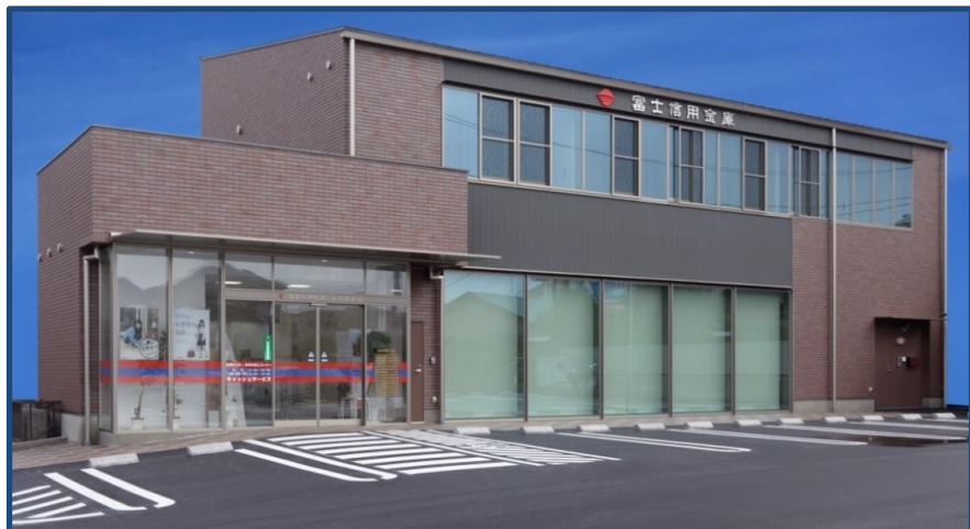
富士信用金庫富士宮支店新築工事
