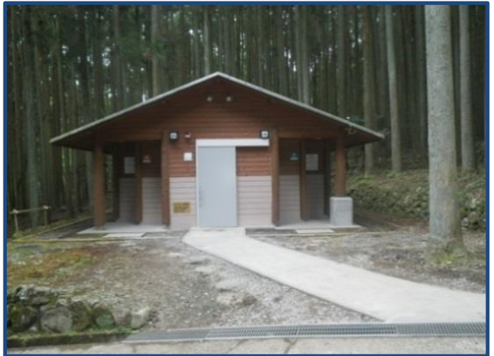
田貫湖キャンプ場レストハウス他トイレ改修工事
