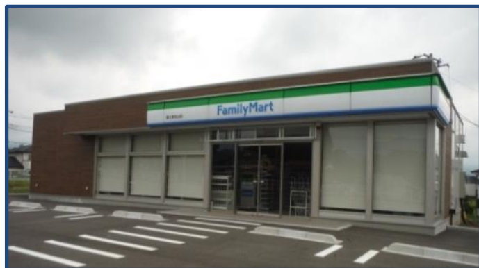
ファミリーマート富士宮北山店新築工事
