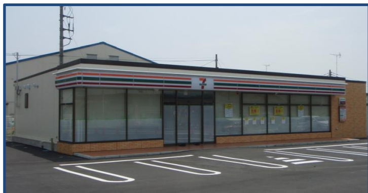
セブンイレブン厚原店新築工事
