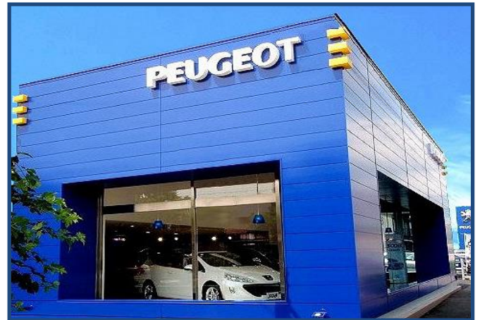
プジョー静岡改修工事
