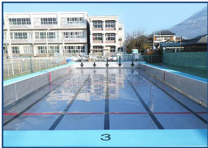
富士宮市立東小学校プール改修工事
