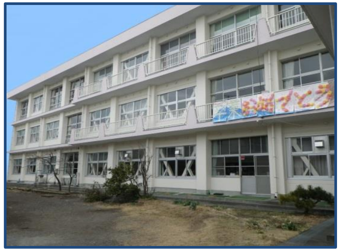
富士宮市立大富士小学校西校舎耐震補強工事
