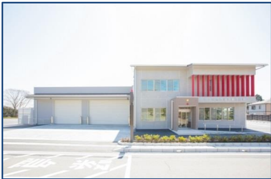
富士宮市西消防署北分署建設工事
