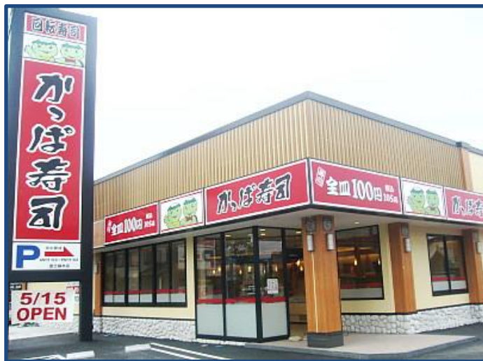
かっぱ寿司柚木店新築工事
