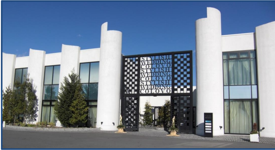
結婚式場COLOVO新築工事
