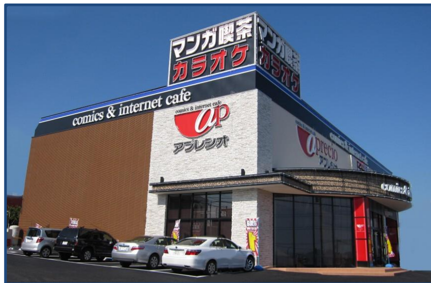
アプレシオ富士宮店新築工事
