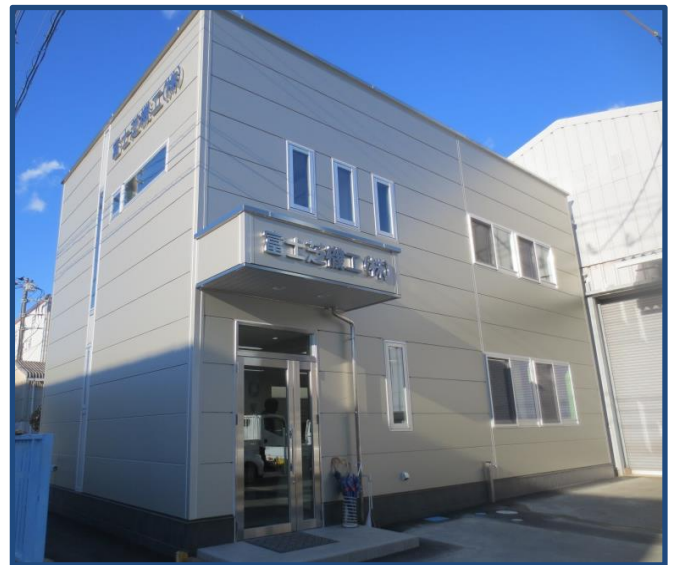
富士芝機工(株)事務所新築工事
