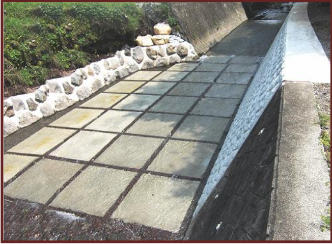
潤井川支川風祭川23年砂防災害復旧工事
