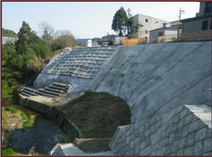
富士川支川小池川県単通常砂防工事（法面保護工）
