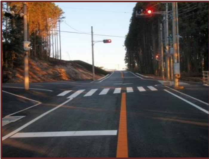
1級市道青木馬見塚線改良工事
