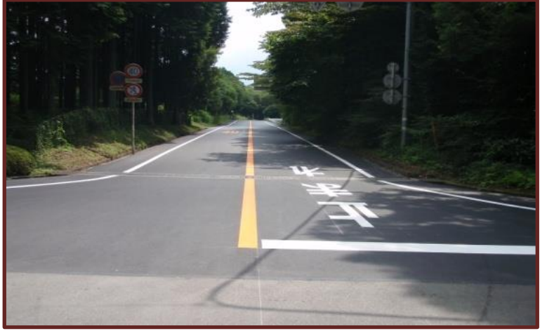
2級市道足形平山線舗装工事
