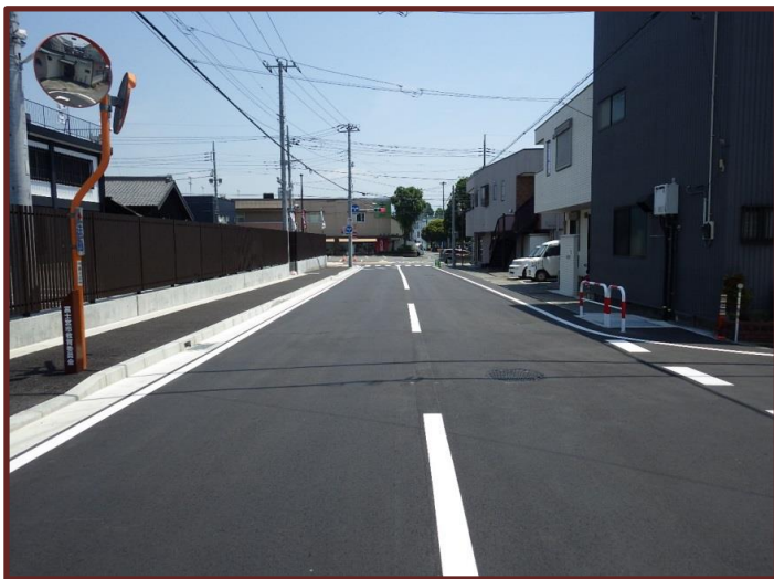
1級市道神立立宿線改良工事
