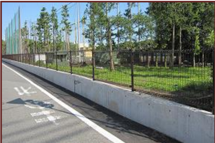
富士宮北高等学校北側フェンス設置工事
