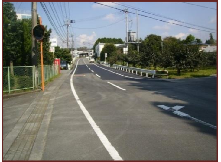
1級市道上蒲沢万野線舗装工事
