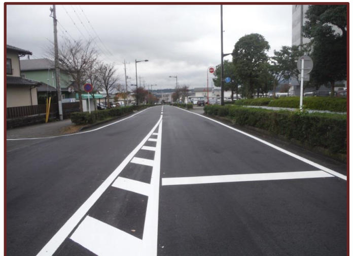
2級市道東新町田中線舗装工事
