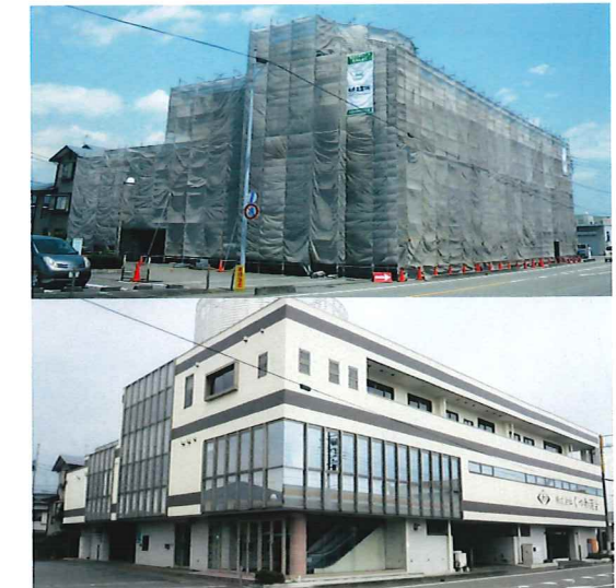
ビルリフォームメンテナンス工事(内装及び外壁改修工事)
