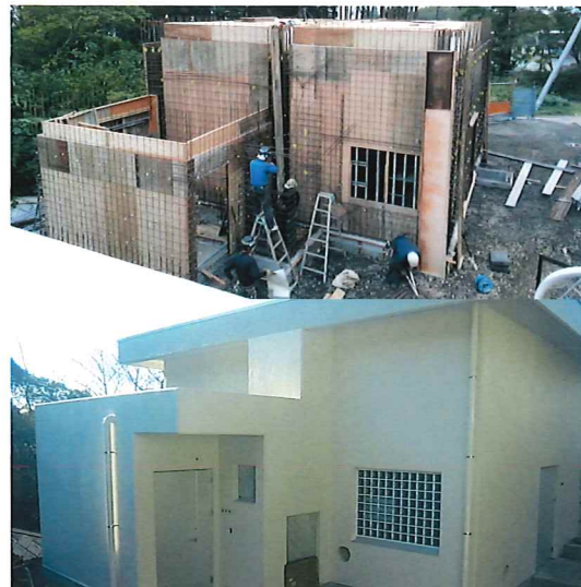
桑崎2号水源地送水ポンプ棟建築工事 構造/鉄筋コンクリート造
