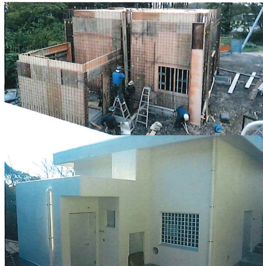
桑崎2号水源地送水ポンプ棟建築工事 構造/鉄筋コンクリート造
