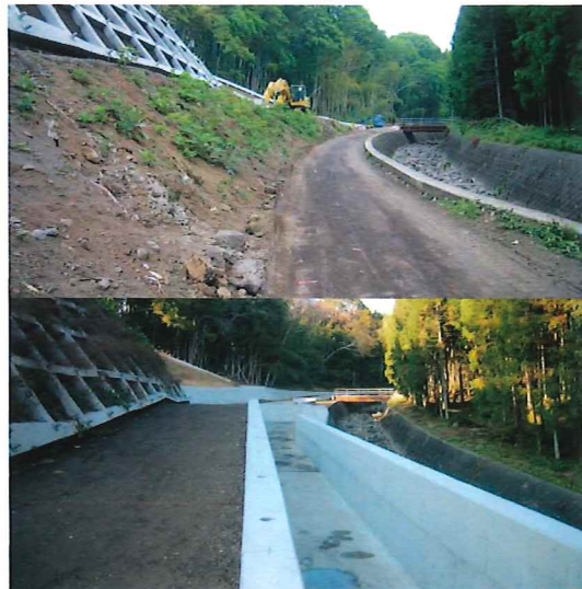
治水対策導水路築造工事 構造/鉄筋コンクリート造
