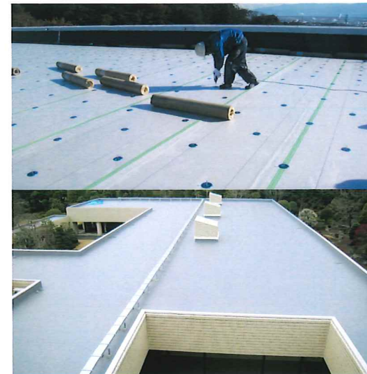
富士市斎場屋上防水改修工事 工法/塩ビシート機械固定工法
