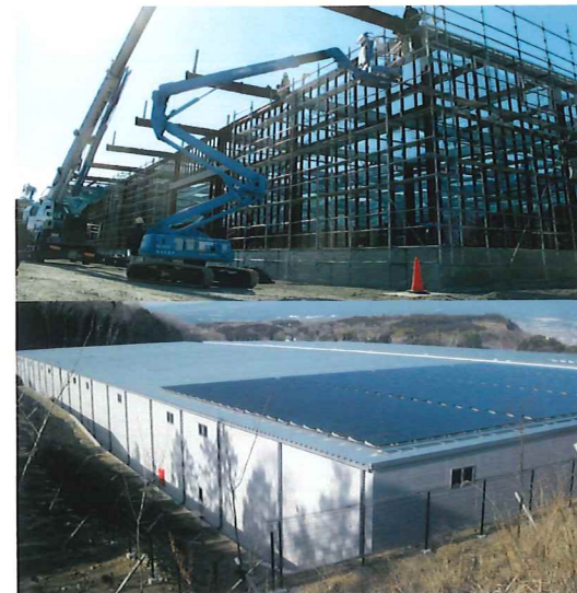
物流倉庫管理棟新築工事 構造/鉄骨造
