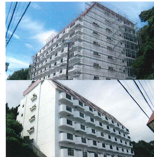
マンション外壁改修工事 工法/弾性塗料吹付
