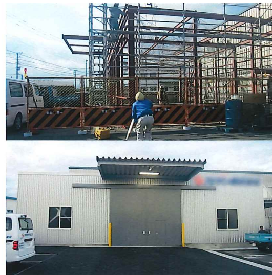
製品倉庫新築工事 構造/鉄骨造
