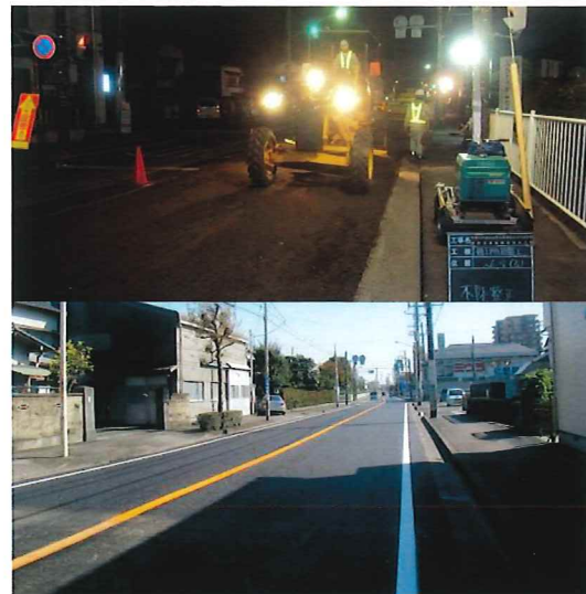
吉原沼津線舗装改良工事 構造/アスファルト舗装
