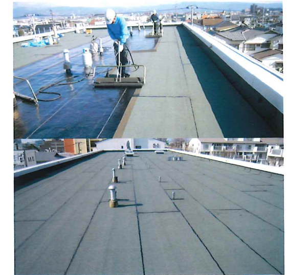
社員寮屋上防水改修工事 ノンケトル冷熱工法(BANKS工法)
